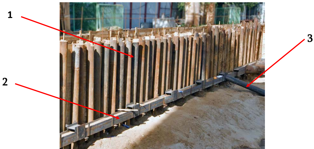
სურ.30. მილოვანი ხიმინჯებისგან მოწყობილი შპუნტური შემოზღუდვა: 1 – მილოვანი ხიმინჯები; 2 – შპუნტური რიგის საყრდენი ქამარი; 3 – შპუნტური რიგის გამბრჯენი სამაგრი.
