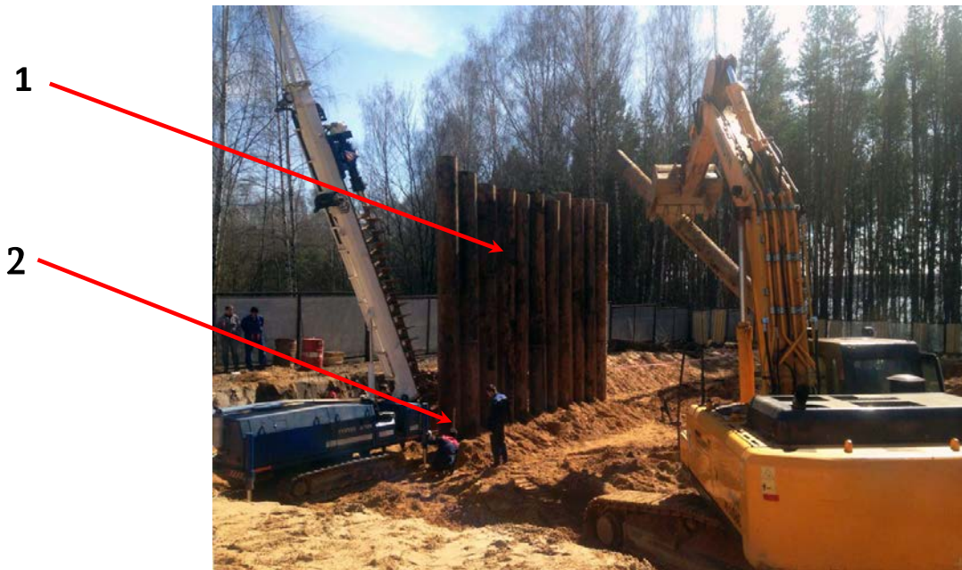
სურ. 31. შპუნტური შემომზღუდავის დაყენების პროცესი: 1 – დასაყენებელი შპუნტური კედელი; 2 – შპუნტის ჩამყვანი მექანიზმი; 3 – მორიგი შპუნტის მიმწოდებელი მექანიზმი
