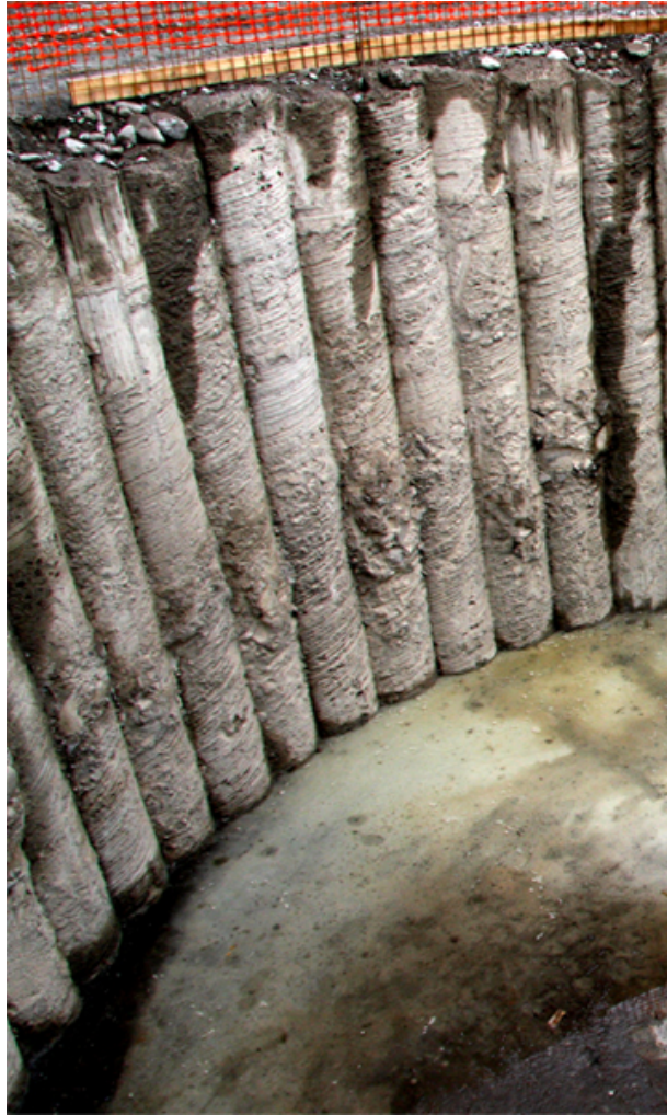
სურ. 24. ბურღვითნატენი ხიმინჯებისაგან შესრულებული ქვაბულის შემომზღუდავი კონსტრუქცია.
