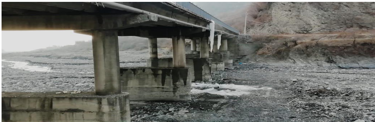
ნახ.1. მდინარე ქურმუხზე არსებული ხიდის ბურჯი
