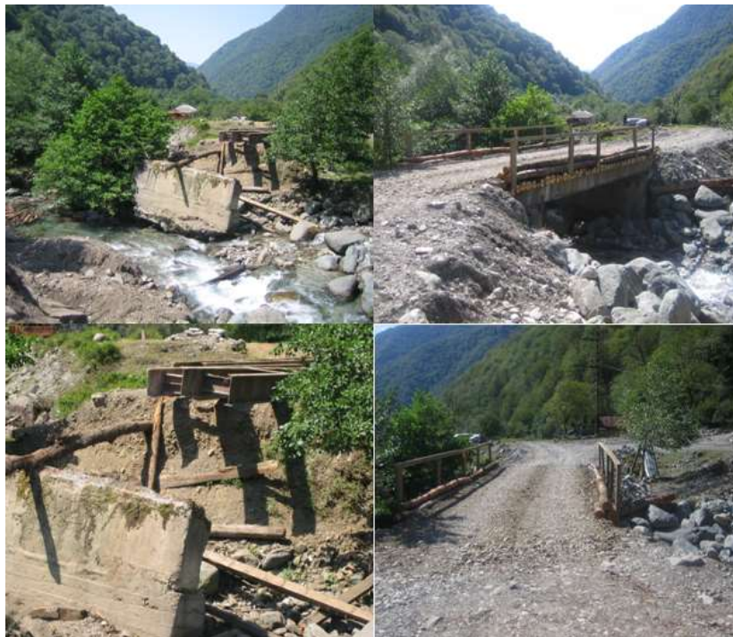
სურ. 4. კოდორის ხეობა, საინჟინრო ოპერაცია – ქვაფხარა-ჩხალთის გზის მონაკვეთი. აიგო რკინაბეტონის კონსტრუქცია, ხიდის სავალ ნაწილზე დაიგო ახალი ხის კოჭები და მოეწყო ქვა-ღორღის საფარი. მისი სავალი ნაწილის გაზარიტი საკმარისია, რომ უზრუნველყოს ერთ ზოლზე დაბალი სიჩქარით (5-10 კმ/სთ) სამოქალაქო და სამხედრო ბორბლიანი და მუხლუხა (მსუბუქი/სატვირთო/დაჯავშნული) ტექნიკის გადაადგილება. ხიდის სიგრძე დაახლოებით 11 მეტრია, ტვირთამწეობა – 15 ტონამდე, სავალი ნაწილის სიგანე – დაახლოებით 5 მეტრამდე; სიმაღლე – დაახლოებით 4 მ
