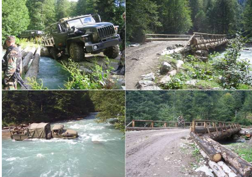
სურ. 3. კოდორის ხეობა, საინჟინრო ოპერაცია – სოფელი საკენის ზემო (ომარიშარა - საკენი - მონაკვეთი) მონაკვეთი. ხის კოჭებით აგებული ხიდი. სავალ ნაწილზე დაიგო ახალი ხის კოჭები და მოეწყო ქვა-ღორღის საფარი. მისი სავალი ნაწილის გაზარიტი საკმარისია, რომ უზრუნველყოს ერთ ზოლზე დაბალი სიჩქარით (5-10 კმ/სთ) სამოქალაქო და სამხედრო ბორბლიანი და მუხლუხა (მსუბუქი/სატვირთო/დაჯავშნული) ტექნიკის გადაადგილება. ხიდის სიგრძე დაახლოებით 16 მეტრია ტვირთამწეობა – 15 ტონამდე, სავალი ნაწილის სიგანე – დაახლოებით 5 მეტრამდე; სიმაღლე – 3,5 მ
