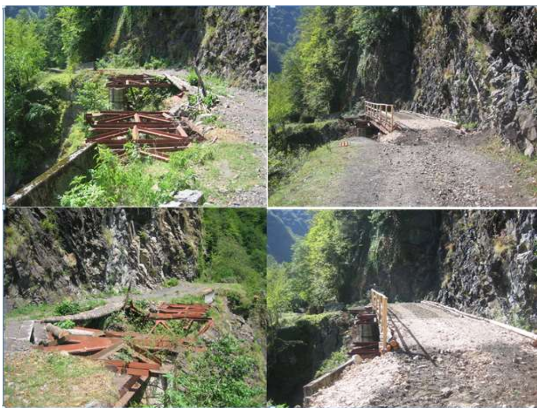
სურ. 2. კოდორის ხეობა, საინჟინრო ოპერაცია – ქვემო ქვაფხარის (ლათა-ქვაფხარის მონაკვეთი) ხიდის სრული აღდგენა. მოხდა რკინაბეტონის კონსტრუქციის გამაგრება, ხიდის სავალ ნაწილზე დაიგო ახალი ხის კოჭები და მოეწყო კვა-ლორდის სავარი. მისი სავალი ნაწილის გაზარიტი საკმარისია, რომ უზრუნველყოს მოძრაობა ერთ ზოლზე დაბალი სიჩქარით (5-10 კმ/სთ). ხიდის სიგრძე დაახლოებით 12 მეტრია, ტვირთამწეობა – 15 ტონამდე, სავალი ნაწილის სიგანე – დაახლოებით 3,5 მეტრამდე; სიმაღლე – დაახლოებით 25 მ.
