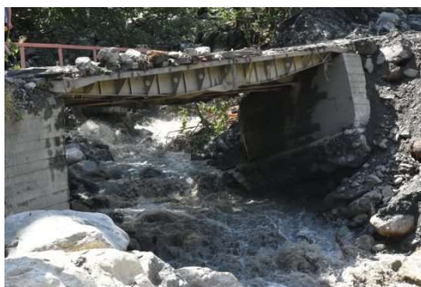
სურ. 3. სტიქიის შედეგად დაზიანებული ხიდი
