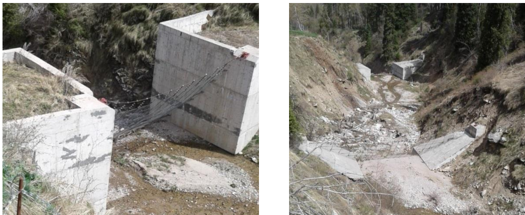
Рис.11. Сетчатые селезадерживающие барражи на р. Батарейка
