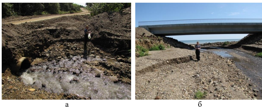
Рис. 4. Отложения селевого потока в бассейне р. Жаровка: а) старый вариант автодороги после расчистки; б) мост, выполняющий роль селепропускного устройства, на новом варианте автодороги. Фото авторов.
