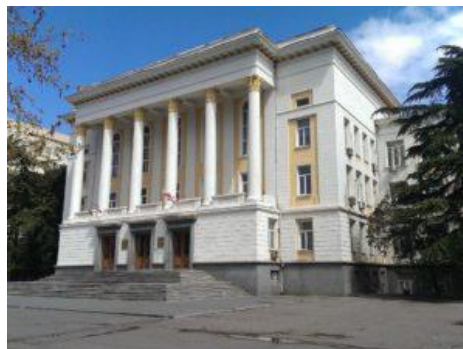
Рис. 2. Административный корпус Грузинского технического университета
