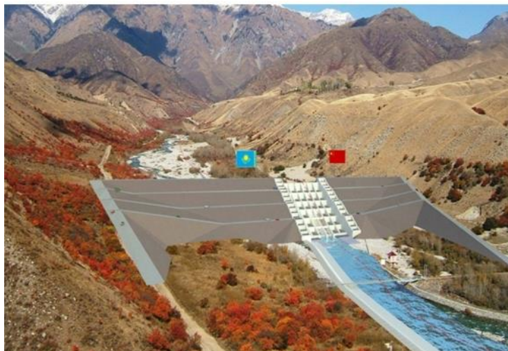
Рис. 6. Вид на селезадерживающую плотину Чукурбулак с нижнего бьефа.
