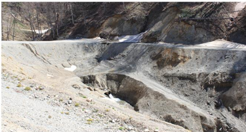
Рис. 2. Автомобильная дорога в верховьях р. Пшеха, построенная с нарушениями существующих норм и правил. Фото Д. Шулякова. Май 2011 г.
