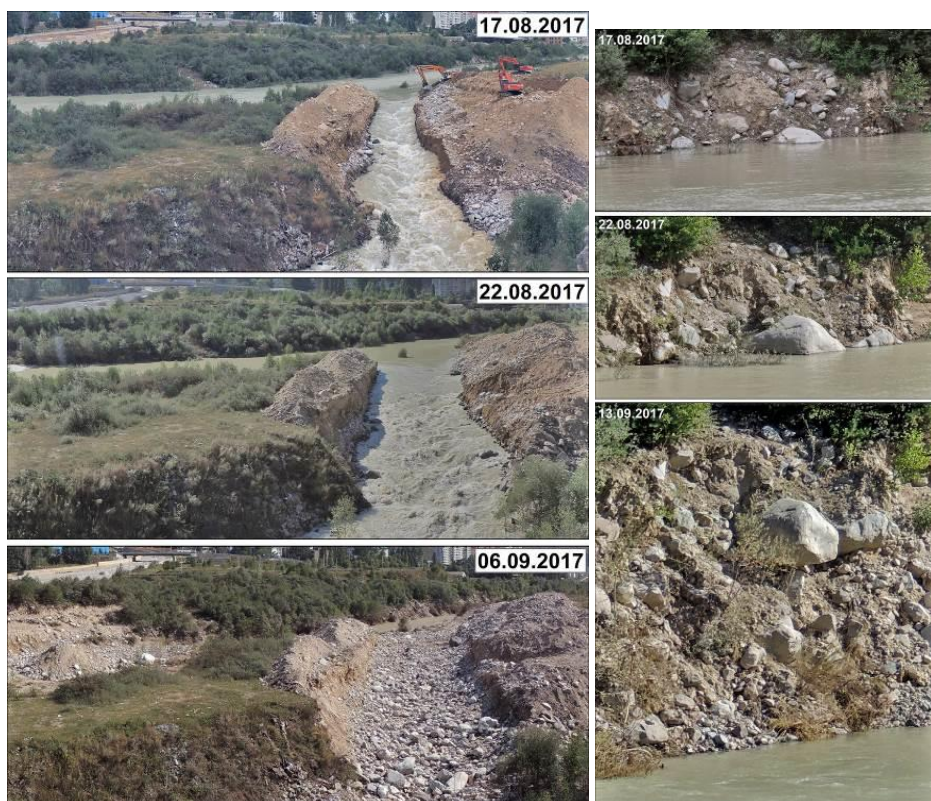
Рис. 13. Прокоп для понижения уровня подпрудного озера на р. Баксан (а) и отметки уровня воды (б) на разновременных фотографиях (фото М.Д. Докукина).
