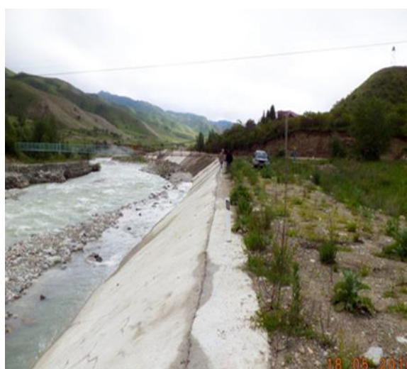
Рис.7. Вид на берегоукрепительную дамбу.
