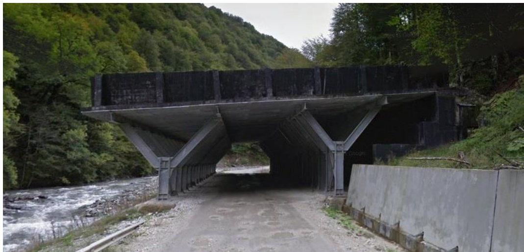
Рис. 8. Селепропускная рамная галерея.
