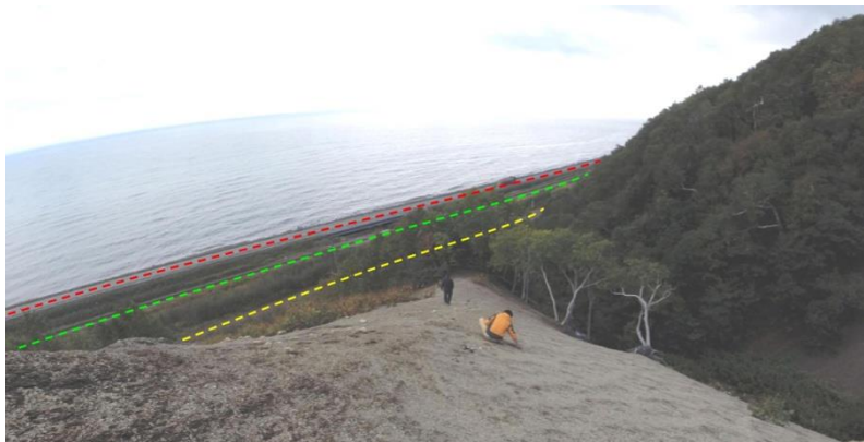
Рис. 3. Один из селевых бассейнов на участке 189-197 км автодороги Южно-Сахалинск - Оха. Желтым показано старое расположение автодороги, красным – новое, зеленым – положение железной дороги. Фото Музыченко А.А.
