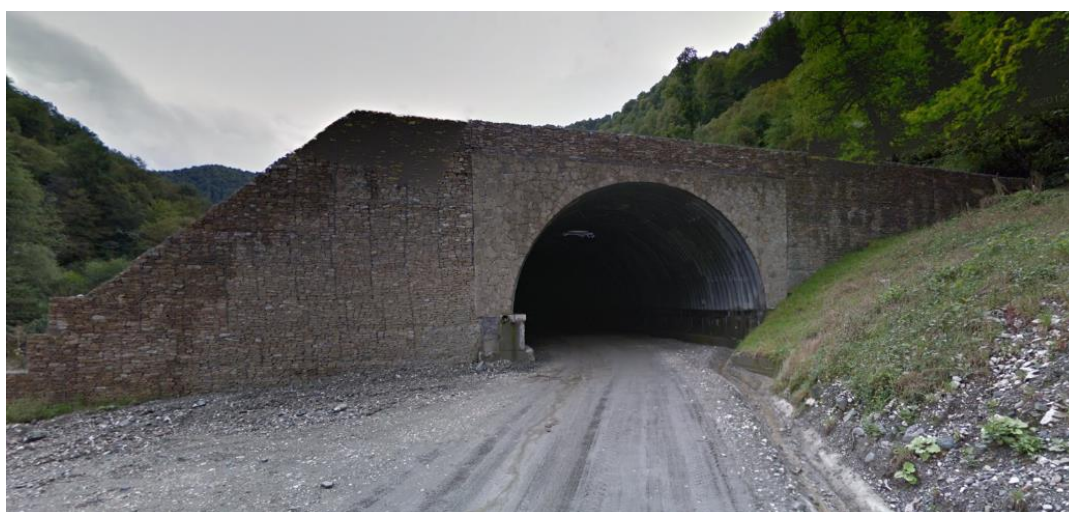
Рис. 9. Селепропускная арочная галерея.
