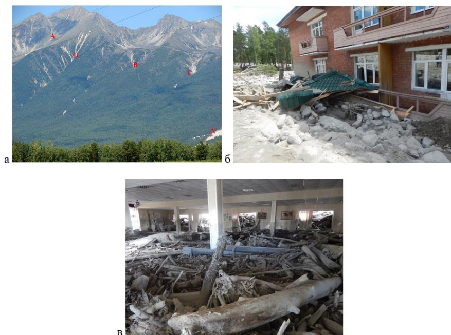
Рис. 4. Последствия селей в районе пос. Аршан, Республика Бурятия, 2014 г.: а) светлые прочесы на склонах Тункинских Гольцов – следы массового проявления селей, оползней-сплывов и эрозии. Селеопаные русла: А – руч. Безымянный, Б - 1-я Шихтолайка, В – руч. Безымянный, Г - 2-я Шихтолайка, Д – Артемьева (фото А.М. Лехатинова). б) заплески со стороны движения селевого потока на уровне верхней части окон второго этажа здания гостиницы «Сааган-Дали». в) характер разрушения селевым потоком одного из корпусов школы для одарённых детей.
