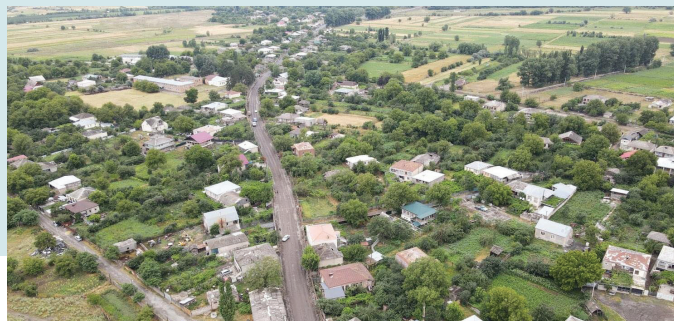
სამუშაოები 3 ლოტად, გზის 32.5 კმ-იან მონაკვეთზე ხორციელდება. სარეაბილიტაციო მონაკვეთი ჭიათურაში იწყება და მესტაფონში სრულდება. განახლებული გზა ჭიათურასა და მესტაფონს უმოკლესი გზით დააკავშირებს.
