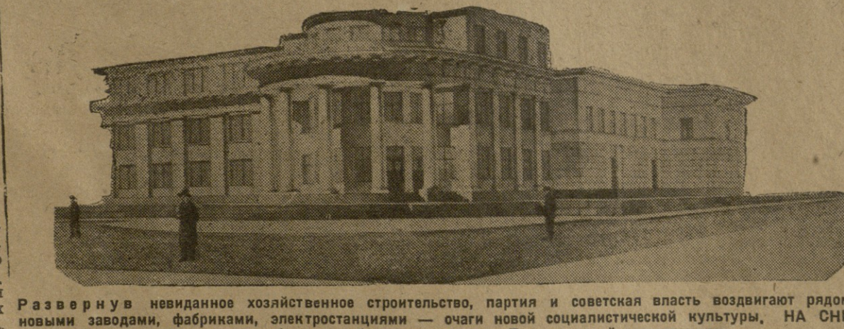
Развернув невиданное хозяйственное строительство, партия и советская власть воздвигают рядом с новыми заводами, фабриками, электростанциями — очаги новой социалистической культуры, НА СНИМКЕ: проект рабочего клуба, строящегося на Ткварчельской гидростанции.
