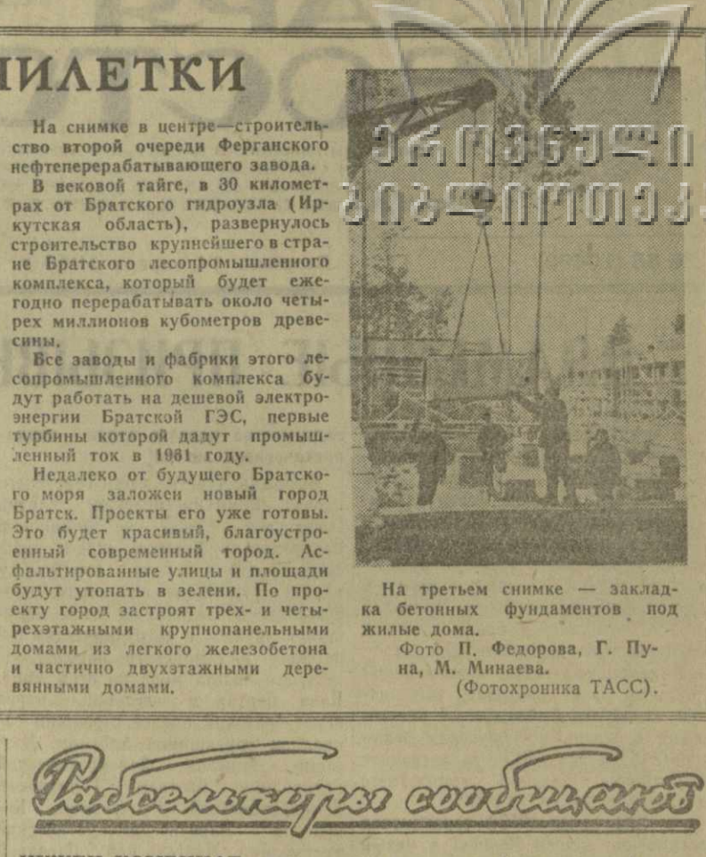
На третьем снимке — закладка бетонных фундаментов под жилые дома.
